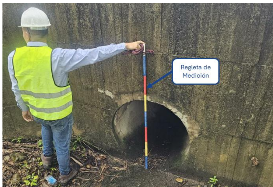
Figura 2-5. Referencia visual levantamiento en campo
