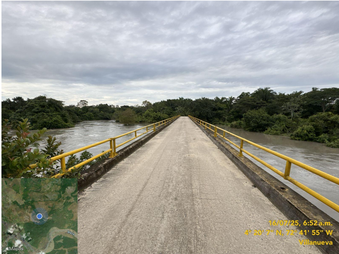
Figura 6-8. Puente sobre el caño Aguaverde.
