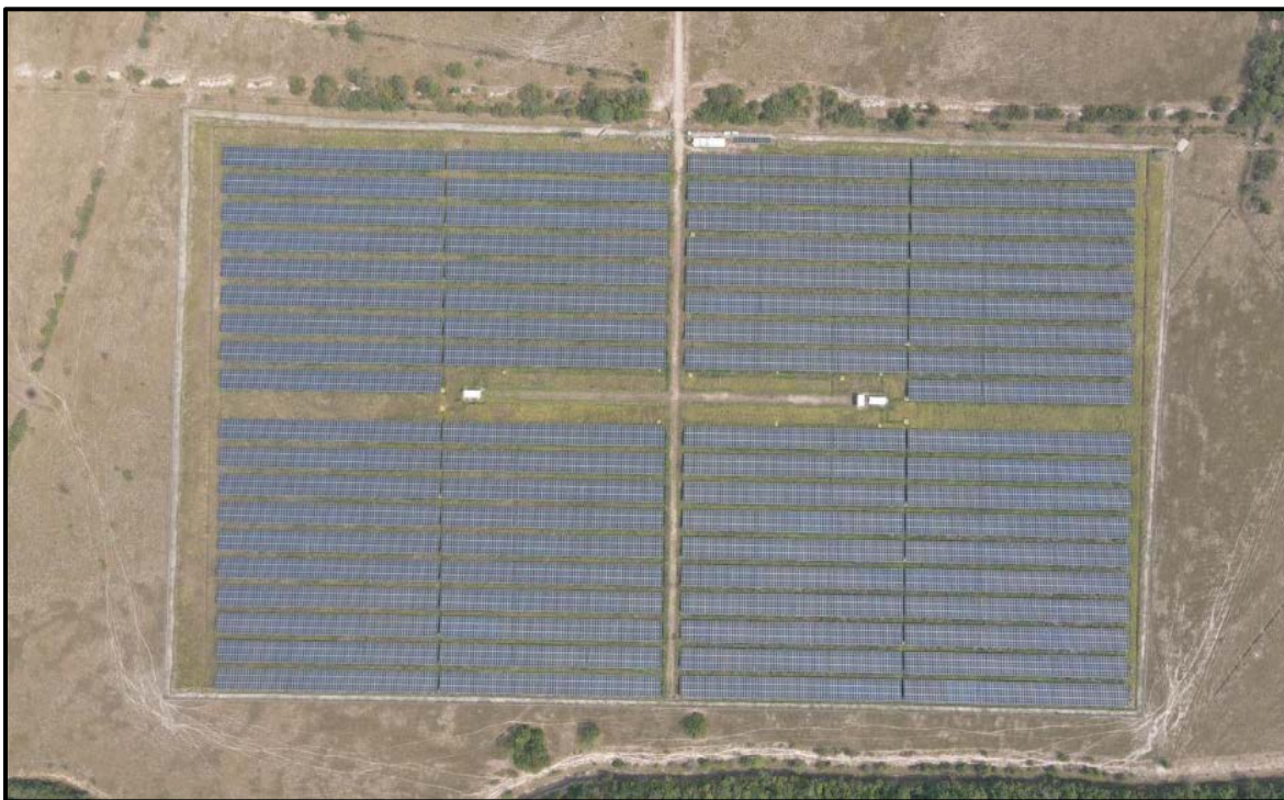
Fotografía No 29. Panorámica aérea de la Granja Solar.
