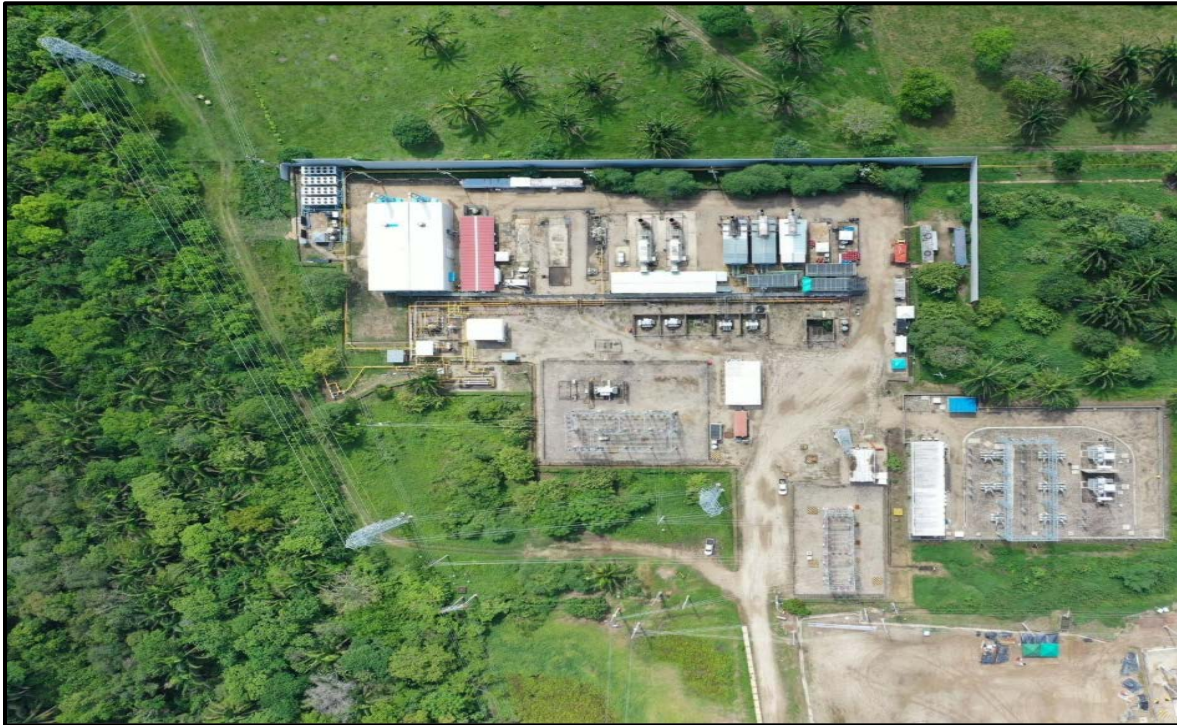
Fotografía No. 8. Vista aérea de la locación Subestación Eléctrica
