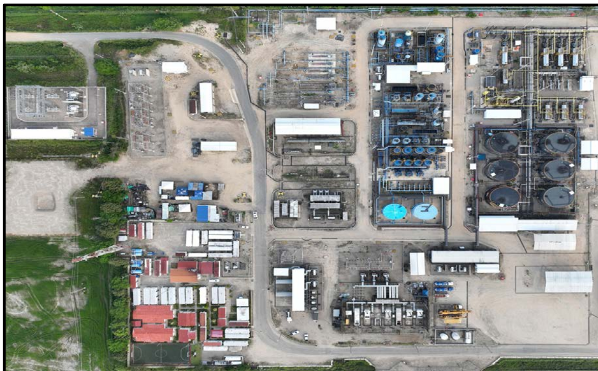
Fotografía No 7. Vista aérea del CPF Jacana
